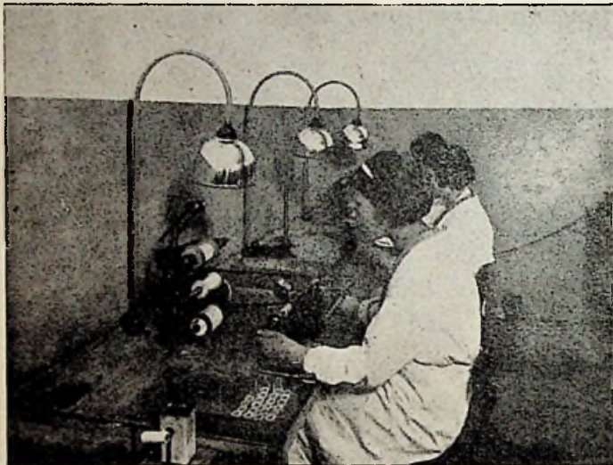
Fig. 6. Het wikkelen der ijzerkernspoeltjes.
